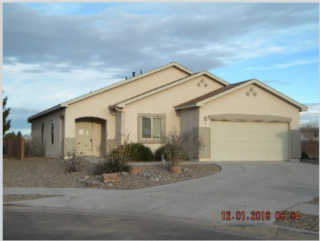
Subject 37 El Camino Loop Nw
